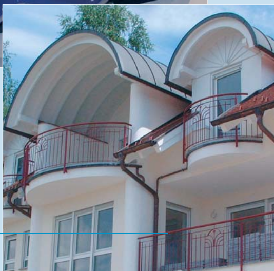
Balkongeländer mit Zierelementen, rot beschichtet
