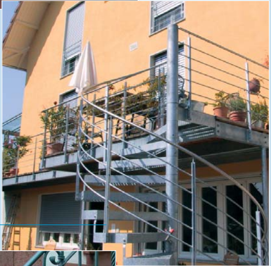
Spindel- treppe und Anbau- balkon verzinkt
