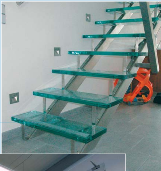
Wangentreppe mit Stufen aus Glas
