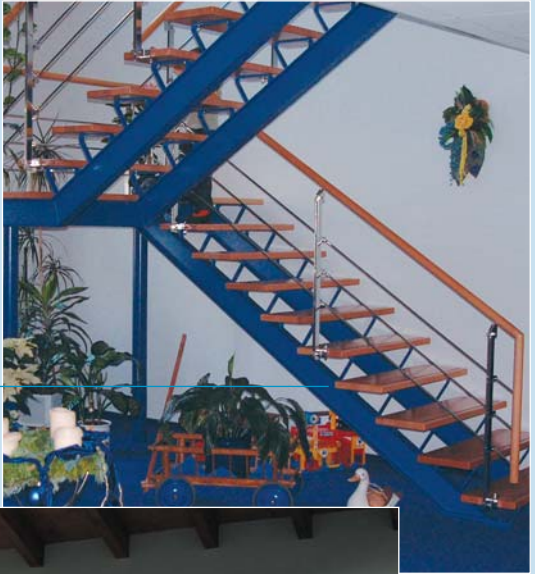
Stahl- treppe mit aufgesattel- ten Holzstufen
