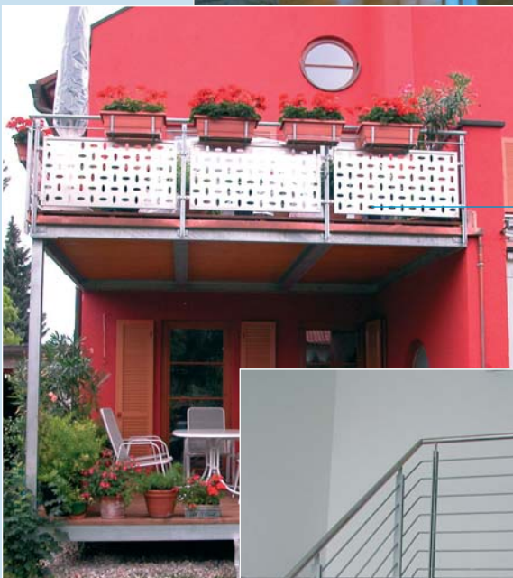
Geländer mit Zierblechen an Anbaubalkon
