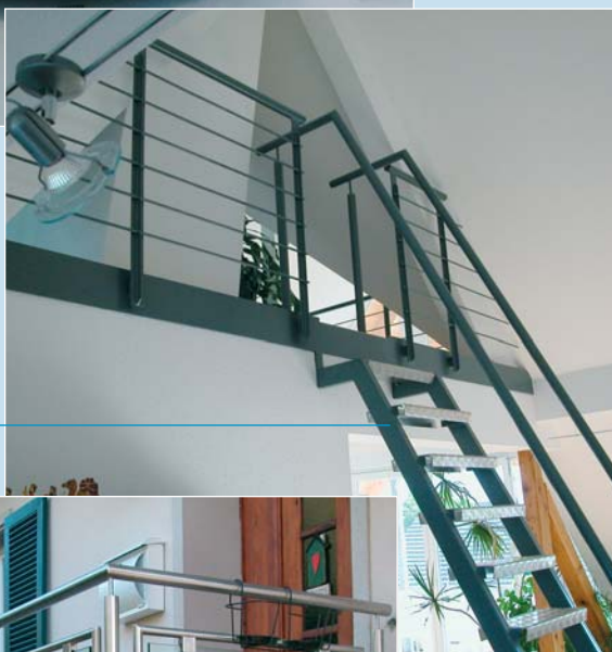
Raumspartreppe mit Stufen aus Aluminium
