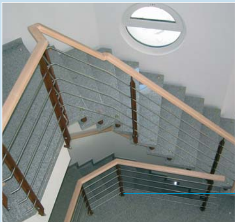
lackierte Pfosten mit Edelstahltraversen und Holzhandlauf
