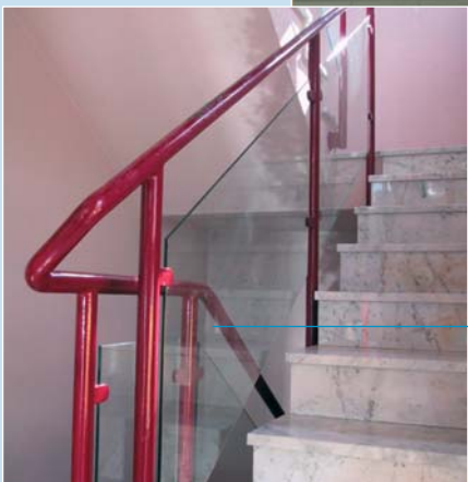
lackiertes Geländer mit Sicherheitsglas
