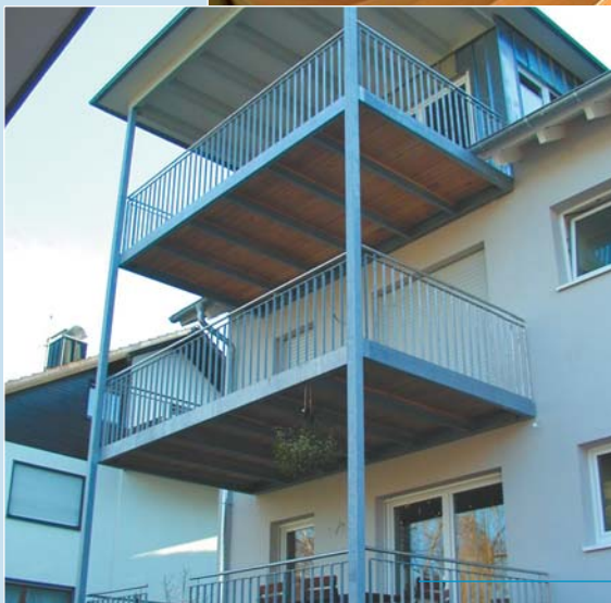
Anbaubalkon, Geländer mit Edelstahl- handlauf
