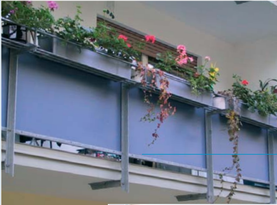
verzinktes Geländer mit Sichtschutz- platten und Blumenkasten- halterung
